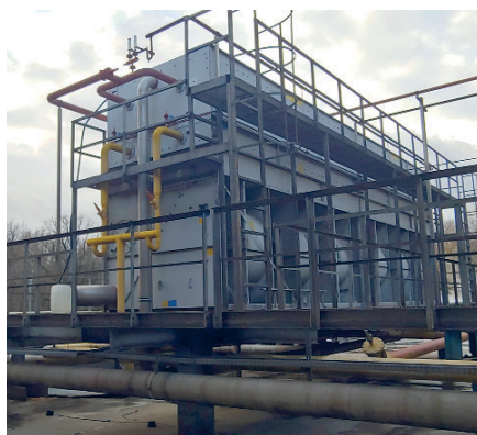
Аммиачный конденсатор испарительного типа Baltimore Aircool
