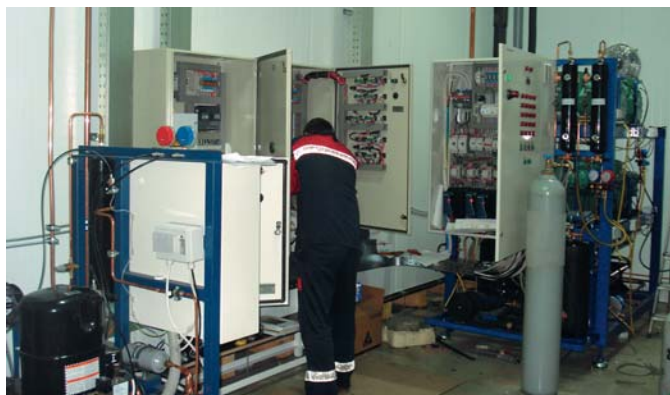
Пусконаладочные работы системы управления и мониторинга низкотемпературного комплекса
