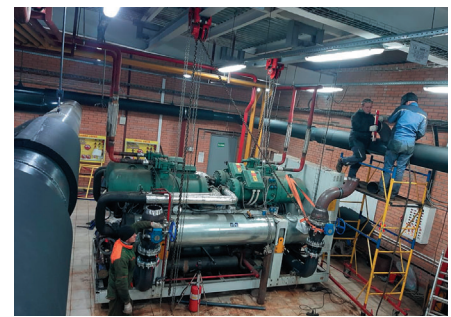
Замена технологических трубопроводов
