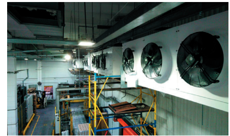
Воздухоохладители на складе хранения готовой продукции
