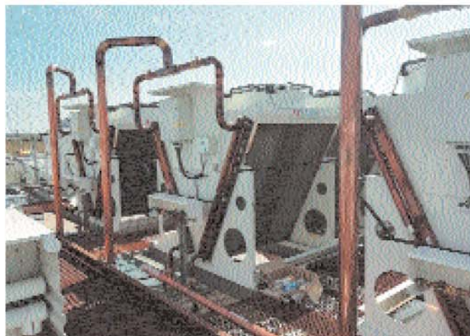
Монтаж конденсаторов с адиабатической системой для генераторов ледяной воды
