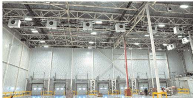
Воздухоохладители в одной из камер складского логистического комплекса в Московской области, установленные специалистами «Фригодизайн»
