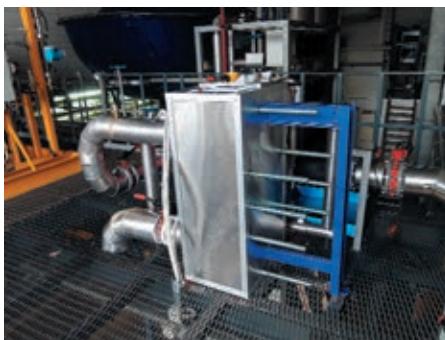
Пластинчатый теплообменник-газификатор углекислоты с центробежным насосом подачи хладоносителя
