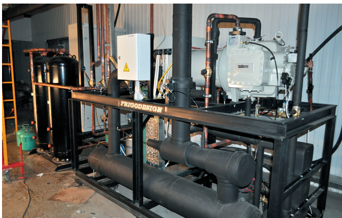
Монтаж компрессорной установки на «ОкеанПремиум»
