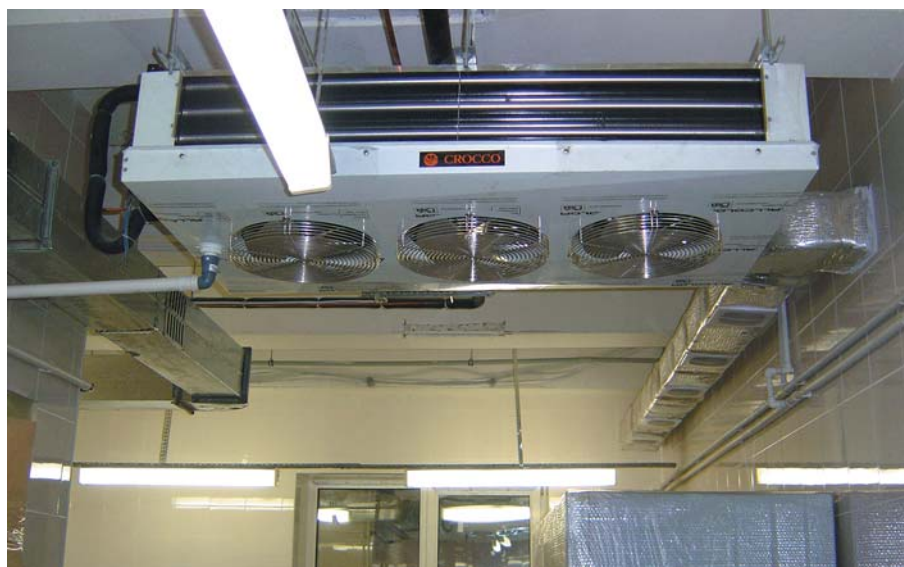
Потолочный двухпоточный воздухоохладитель CROCCO
