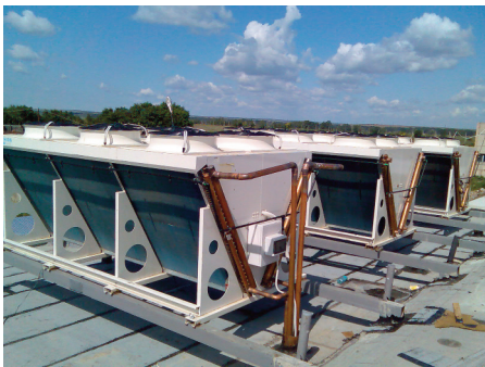
Рис. 2. Конденсаторы с адиабатической системой охлаждения
