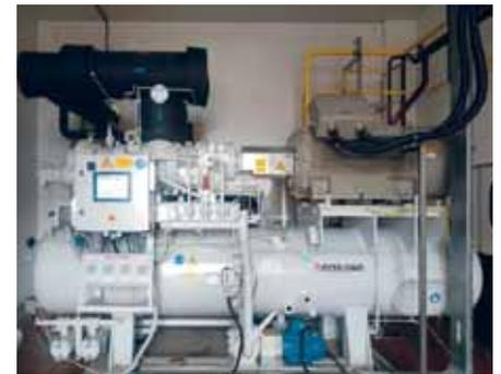
Для плавного регулирования производительности компрессора используется частотный преобразователь его привода, что позволило сократить энергопотребление при работе холодильного агрегата в случае неполной загрузки производственной линии, запускать компрессоры без высоких значений пусковых токов.
