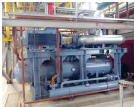
Здесь нами проведены работы по техническому перевооружению аммиачной системы холодоснабжения. Поставлен полный комплект холодильного оборудования для монтажа дополнительной системы холодоснабжения:
