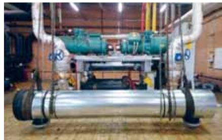
тельности четырех конденсаторов воздушного охлаждения спроектирована, поставлена и смонтирована адиабатическая система охлаждения воздуха на входе воздушного потока в конденсатор путем мелкодисперсного распыления воды в его потоке.
