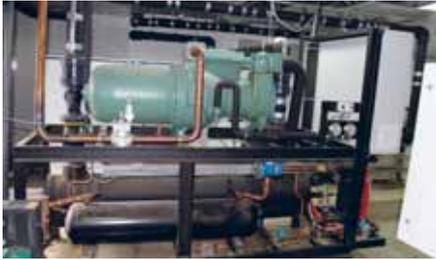
Изготовлена и поставлена холодильная установка холодопроизводительностью 226 кВт. Температура раствора пропиленгликоля на входе в установку +4°C, на выходе 0°C.
