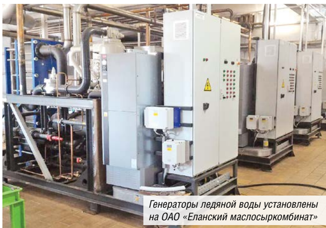
Генераторы ледяной воды с пластинчатыми испарителями производительностью 87 м³/ч по ледяной воде 1,5±0,5°C
