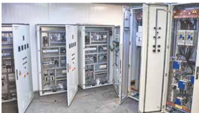
Рис. 4. Участок сборки шкафов управления и мониторинга на производстве ООО «Фриготрейд»
