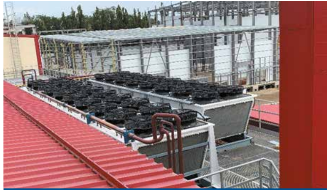
Рис. 3. Воздушные конденсаторы с адиабатической системой охлаждения воздуха, поставленные ООО «Фриготрейд»
