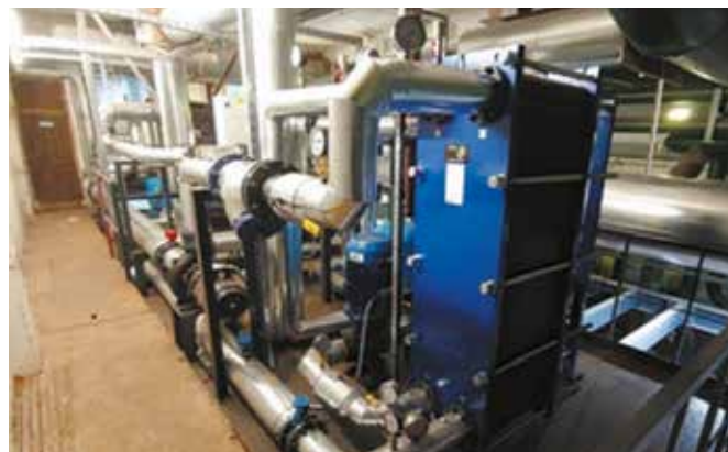
Рис. 2. Пластиначатый теплообменник с насосным агрегатом системы фрикулинга
