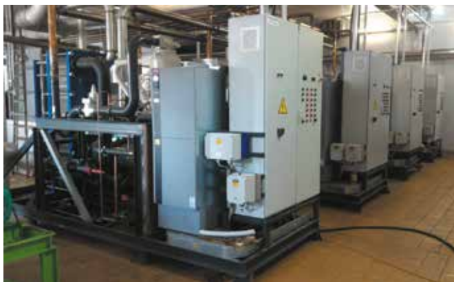
Рис. 1. Четыре генератора ледяной воды Фригодизайн® на Еланском маслосыркомбинате, Волгоградская обл.
