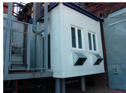
Модульное машинное отделение на сваях производства ООО «Фриготрейд» (Московский холодильник №14)
