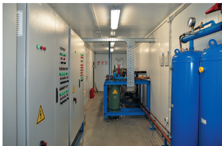
Пример отделки и компоновки внутреннего объема 40-футового контейнера системы холодоснабжения Фригодизайн®
