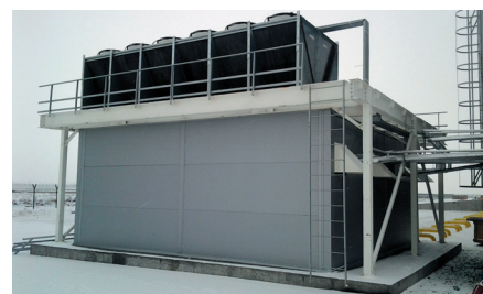
Внешний вид модульного компрессорного отделения после сдачи в эксплуатацию
