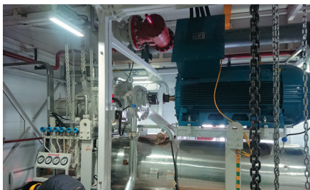
Завершение монтажа компрессорного агрегата МУСОМ в блочно-модульном контейнере
