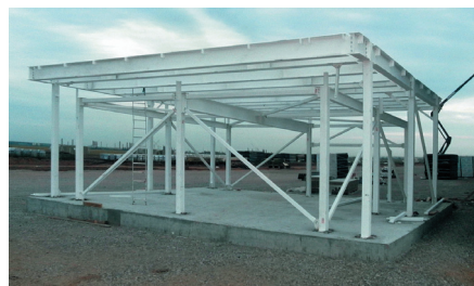
Силовой каркас модульного компрессорного отделения системы холодоснабжения складского терминала в Поволжье
