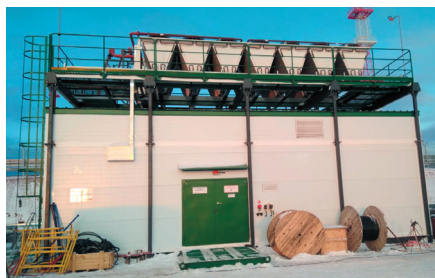
Блочно-модульная система холодоснабжения после сборки на нефтяном месторождении
