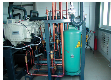
Компрессорная холодильная станция в модульном машинном отделении (Московский холодильник №14)
