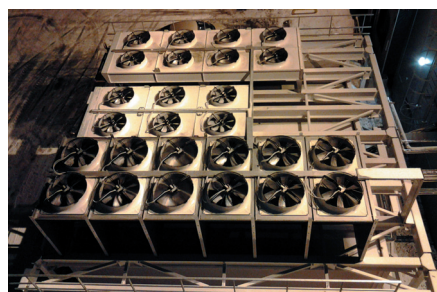
Конденсаторы на верхней силовой раме модульного отделения
