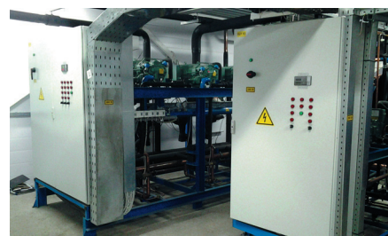
Многокомпрессорные агрегаты внутри модульного отделения
