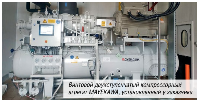
Двухкомпрессорный агрегат холодоснабжения фризеров после монтажа у заказчика
