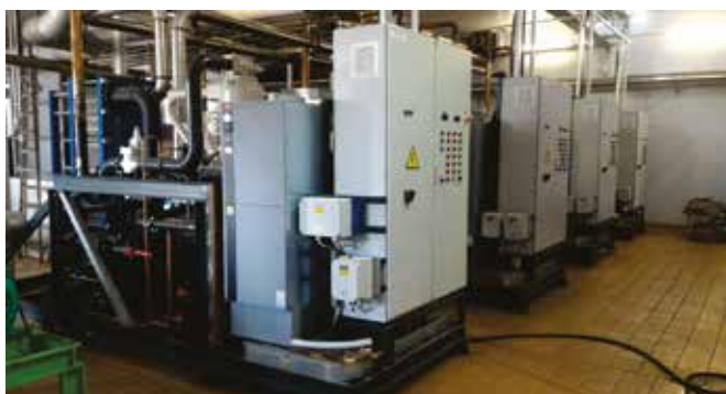
Рис. 1. Четыре установки ледяной воды в проточных пластинчатых испарителях, установленных на ОАО «Еланский маслосыркомбинат»
