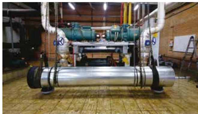
Рис. 6. Замена кожухотрубных испарителей
