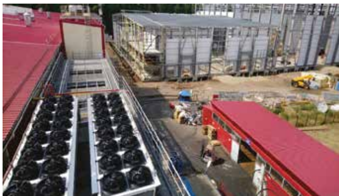
Рис. 5. Конденсаторы холодильных установок
