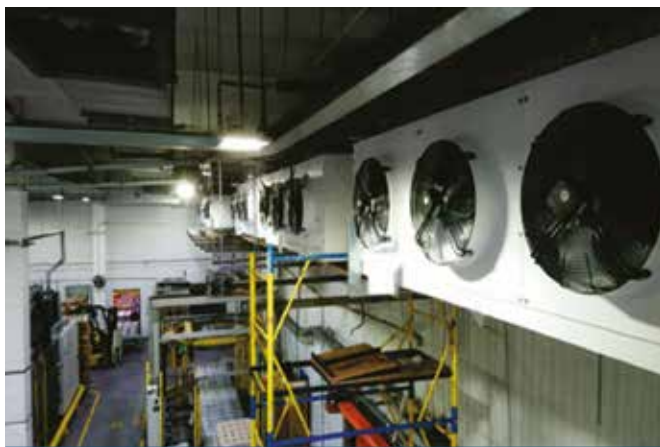
Рис. 7. Новые воздухоохладители склада хранения готовой продукции
