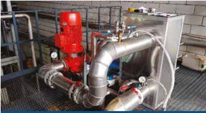
Рис. 3. Насосный агрегат Фригодизайн® с промежуточным теплообменником системы фрикулинга
