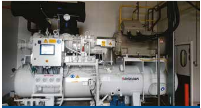
Рис. 4. Холодильный агрегат туннеля заправки мороженого
