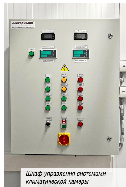
Машинное отделение контейнерной климатической камеры
