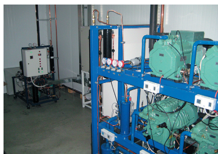
Двухкаскадная четырехкомпрессорная холодильная установка для низкотемпературной камеры ( -55^{\circ}\text{C} ) хранения кисломолочных бифидокультур
