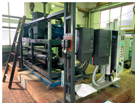
Шкаф управления компрессорным агрегатом Фригодизайн® с частотными преобразователями привода компрессоров
