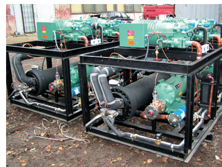
Две из четырех установок предварительного охлаждения жидкости на винтовых компрессорах для химического предприятия в Красноярском крае
