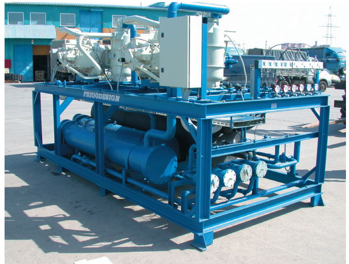
Генератор ледяной воды с кожухотрубным испарителем на молокозаводе в г.Каменск-Уральский
