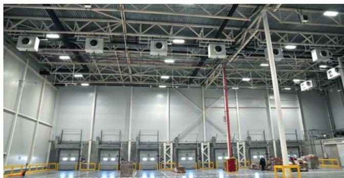
На «Нижевартовский колбасный завод» для камер хранения колбас были поставлены холодильные установки производительностью 335 кВт ( $-7^{\circ}\text{C}$ ) и 360 кВт ( $-2^{\circ}\text{C}$ ). Обе холодильные установки оборудованы системой рекуперации тепла для получения горячей воды для технологических нужд.
